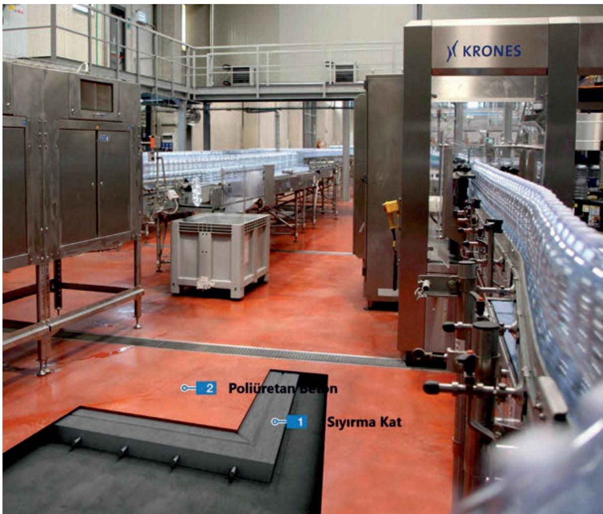
Kapalı gözenekli, geçirimsiz, düz bitiş yüzeyi agresif kimyasallara karşı mükemmel dayanıma sahiptir. Benzersiz özel poliüretan reçinelerin birleşmesinden oluşan zemin kaplama sistemidir.
